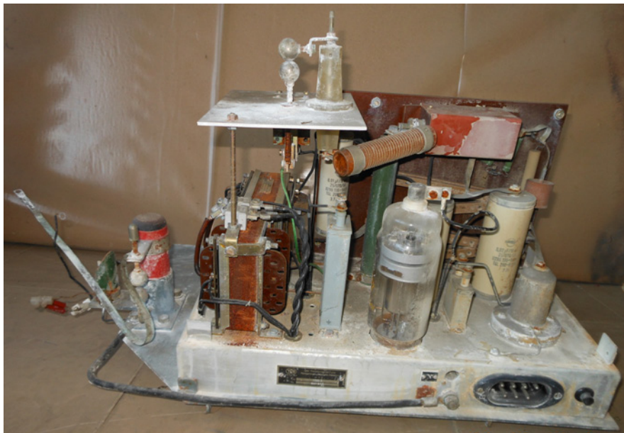
Слика 9.4 – Фотографија неисправног уређаја за контролисано окидање ударног генератора
