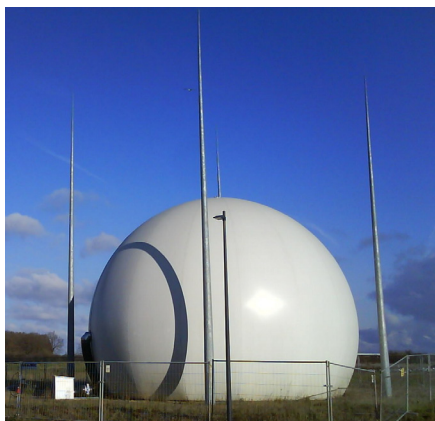
Слика 6.3 – Заштита експерименталне станице за изучавање микроорганизама примјеном екстерног система заштите [198]
