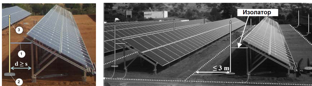
Слика 6.2 – Заштита соларних електрана од директних атмосферских пражњења примјеном екстерног система заштите [197]
